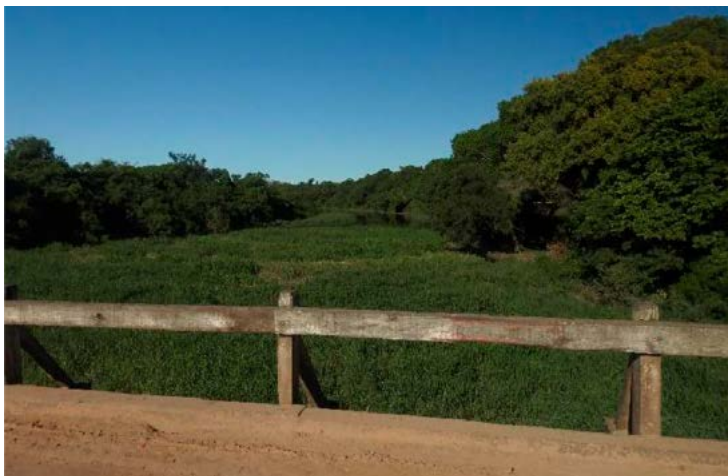
Figura 9: colonización vegetal en el interior del río (subtramo 1, Puente Bergagno, Av. 25 de Mayo, Fontana, Chaco).
